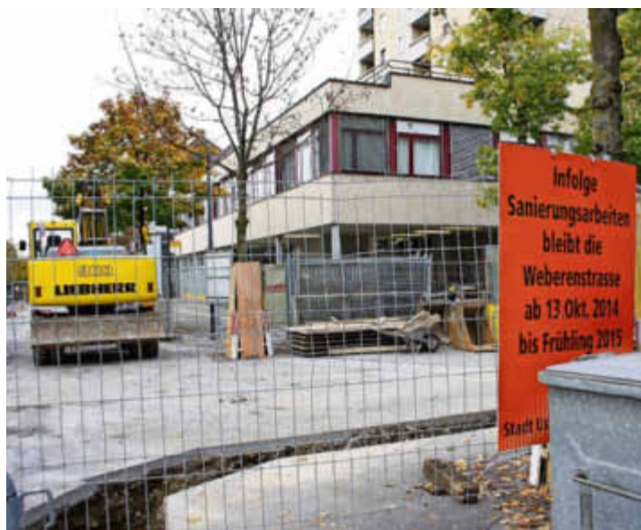
Kein Durchkommen: Der untere Teil der Weberstrasse ist bereits eine Baustelle, nur Fussgänger können sie noch passieren. Eduard Gautschi
